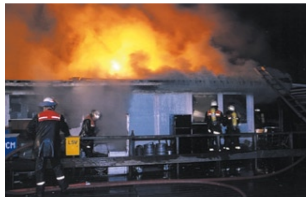
Abb. 1: Restaurantbrand an der Außenalster in Hamburg am 30.08.1997 [1] Gebäude: Überwiegend Holzbauweise, eingeschossig auf Holzpfählen gegründet Brandursache: Technischer Defekt in der Elektroinstallation, wahrscheinlich in Folge von Materialermüdung Schaden am Gebäude: Zerstörung bis auf Pfahlgründung und Balkenrost Schadenshöhe: ca. 0,5 Millionen EUR
