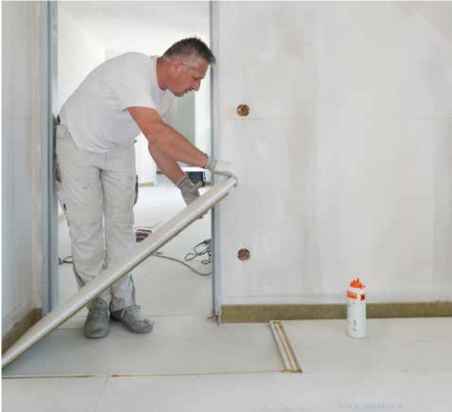
Verlegung eines Fermacell Trockenestrich-Elements.
